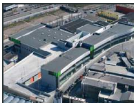
Naves Industriales y Comerciales en Terrassa (PIC Vallès)
