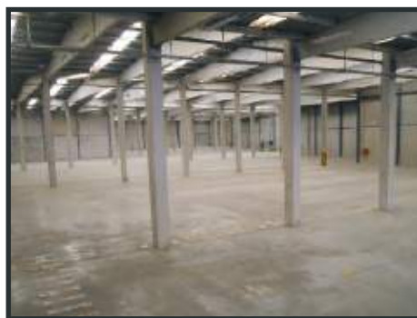
Nave logística aislada en Montornès (El Raiguer)
