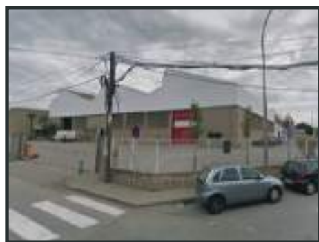
Nave en Santa Perpètua de la Mogoda
